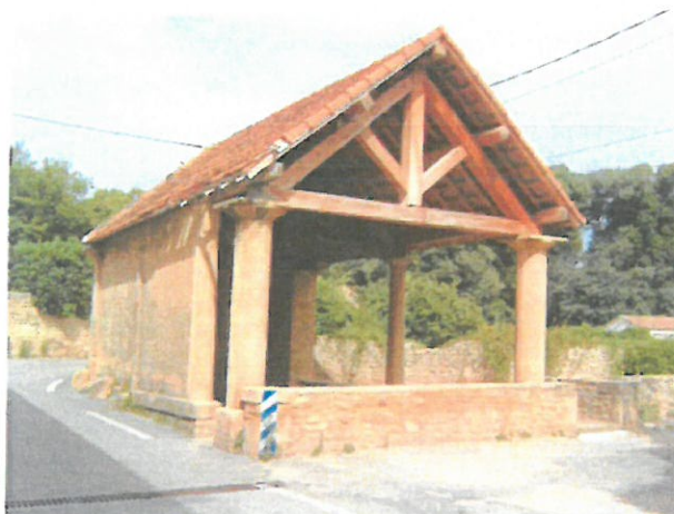
Face sud-ouest et nord-ouest
