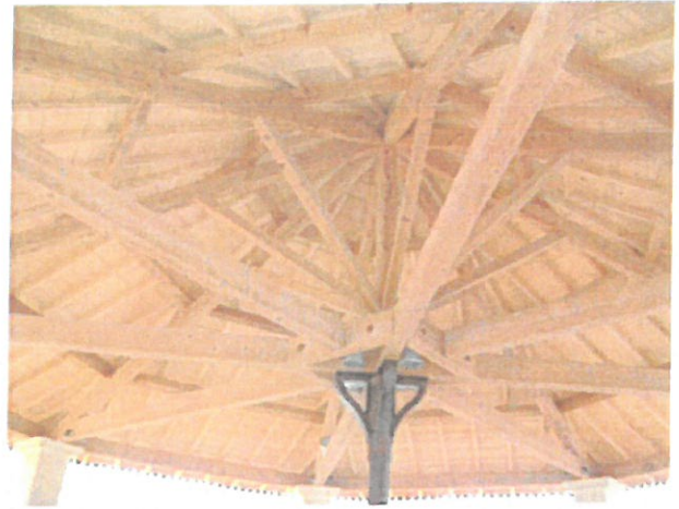
Charpente en bois © Bochet F. (2007).
